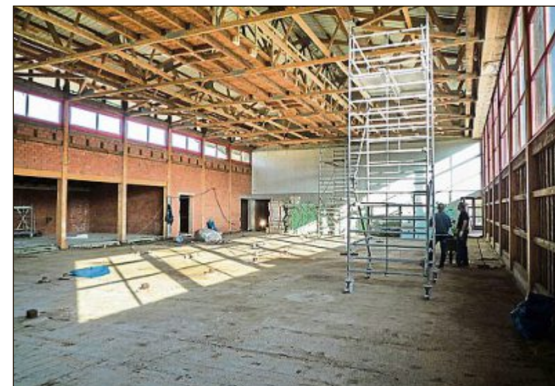
Während der Bauarbeiten.
